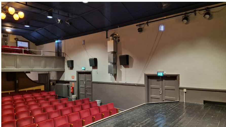
Biosalongen mot norr. Två uppsättningar utrymningsdörrar, grå spegelindelade pardörrar med profilerade foder. Grå profilerad bröstningslist avslutar bröstningen.
