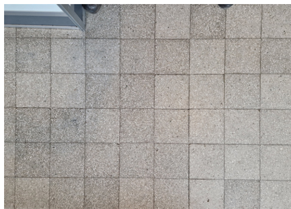
Golvet i foajen är ett terrazzoliknande klinker.
