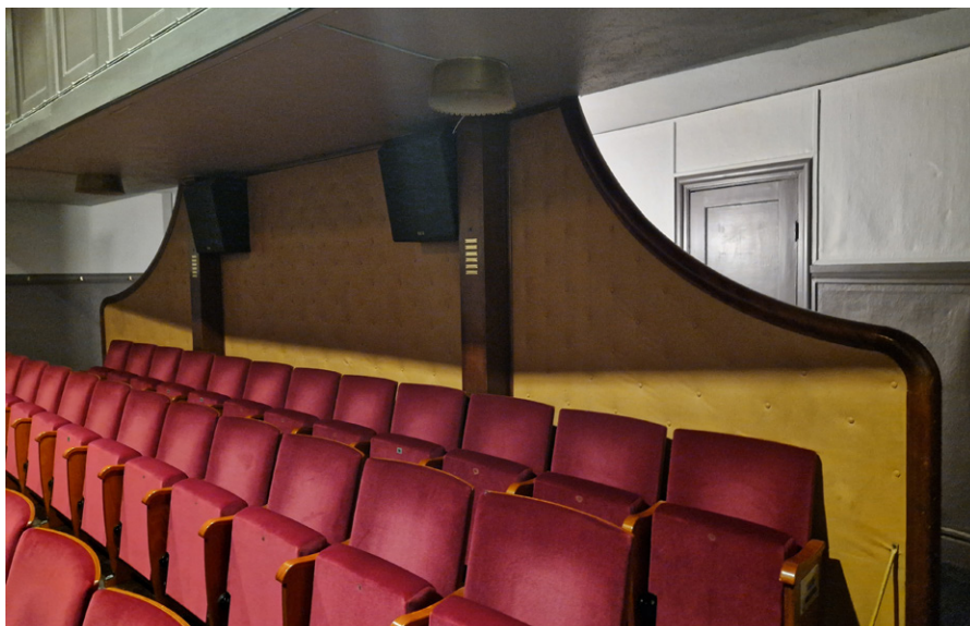
Den avskiljande väggens insida, sedd från biosalongen.
