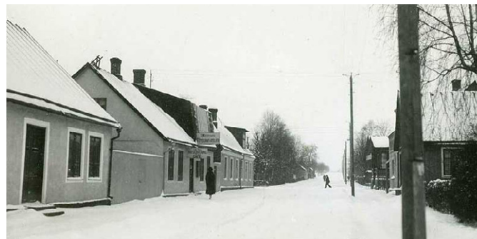
Vy mot väst längs Prostgatan. Prostgatan 7-11 till vänster, med byggnaden som nu inrymmer Tahiti condis närmast. Okänt årtal. Källa: Gammalstorp
