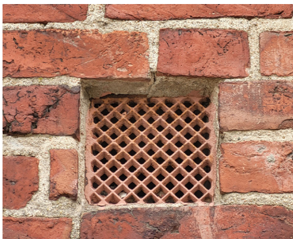
Dekorativa ursprungliga ventilationsgaller i huvudfasaden mot Nygatan.
