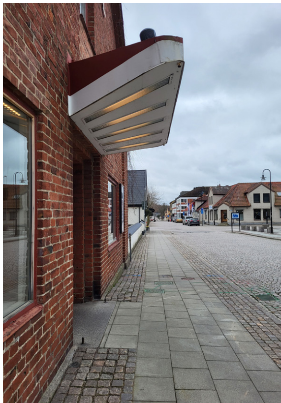
Skärmtaket över entrén är uppåtvinklat, trapetsformat och försett med inbyggd strålformad belysning.
