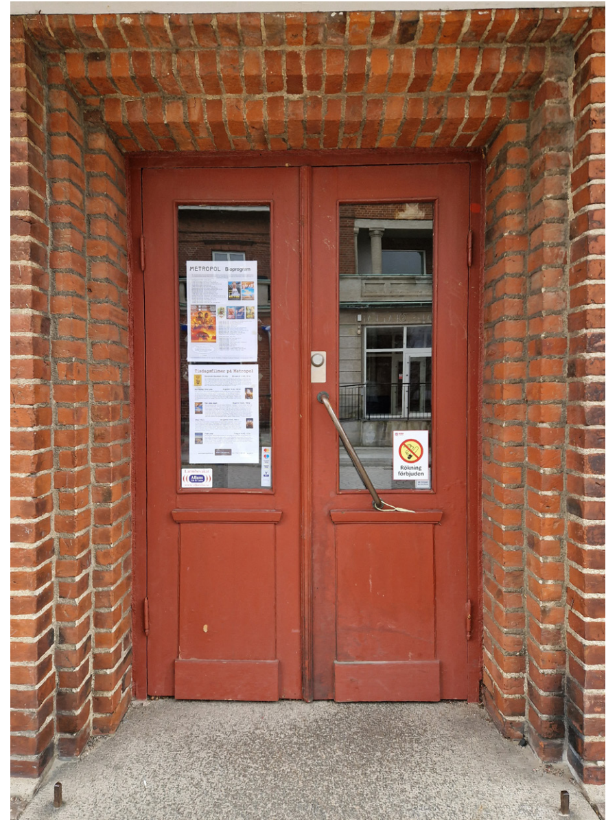
Huvudentrén har en glasad röd pardörr med spegelfyllnader nedtill, infattad i en nisch med trappande tegelskift.
