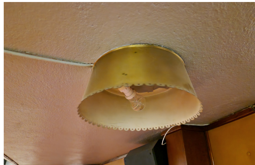
Mässingsplafonder på balkongens undersida.
