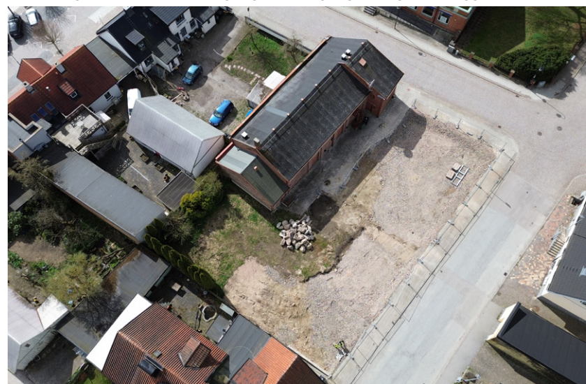
Fastigheten Hasslarp 14 från ovan. Sadeltaket är klätt med svart papp. Biografbyggnaden angränsar till avrivna tomter i norr.
