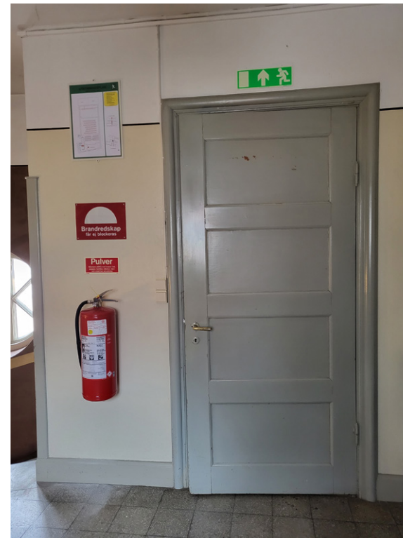
Ursprunglig trädörr till biosalongens balkong. Profiletrade dörrfoder, golvsocklar, och hörnlist.
