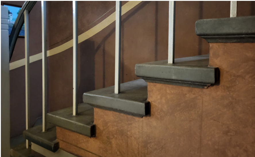
Trappstegen av betong har profilerade avslut.
