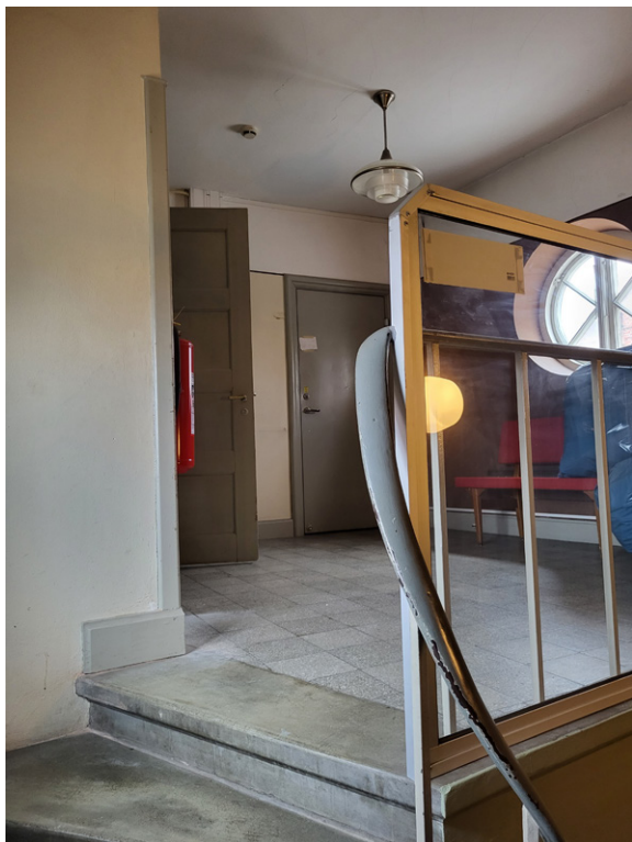
Räcket upptill har kompletterats med ett sekundärt glasräcke.
