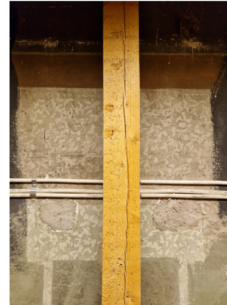
Väggparti bakom bioduken, sannolikt ursprunglig färgsättning i salongen.
