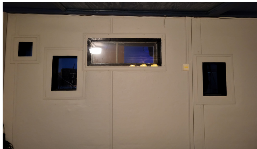
Bakre vägg på balkongen med inramade fönsterhål för projektorer.
