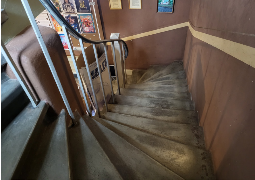
Trappan till foajéns övre plan är av betong och har ett svängt smidesräcke.
