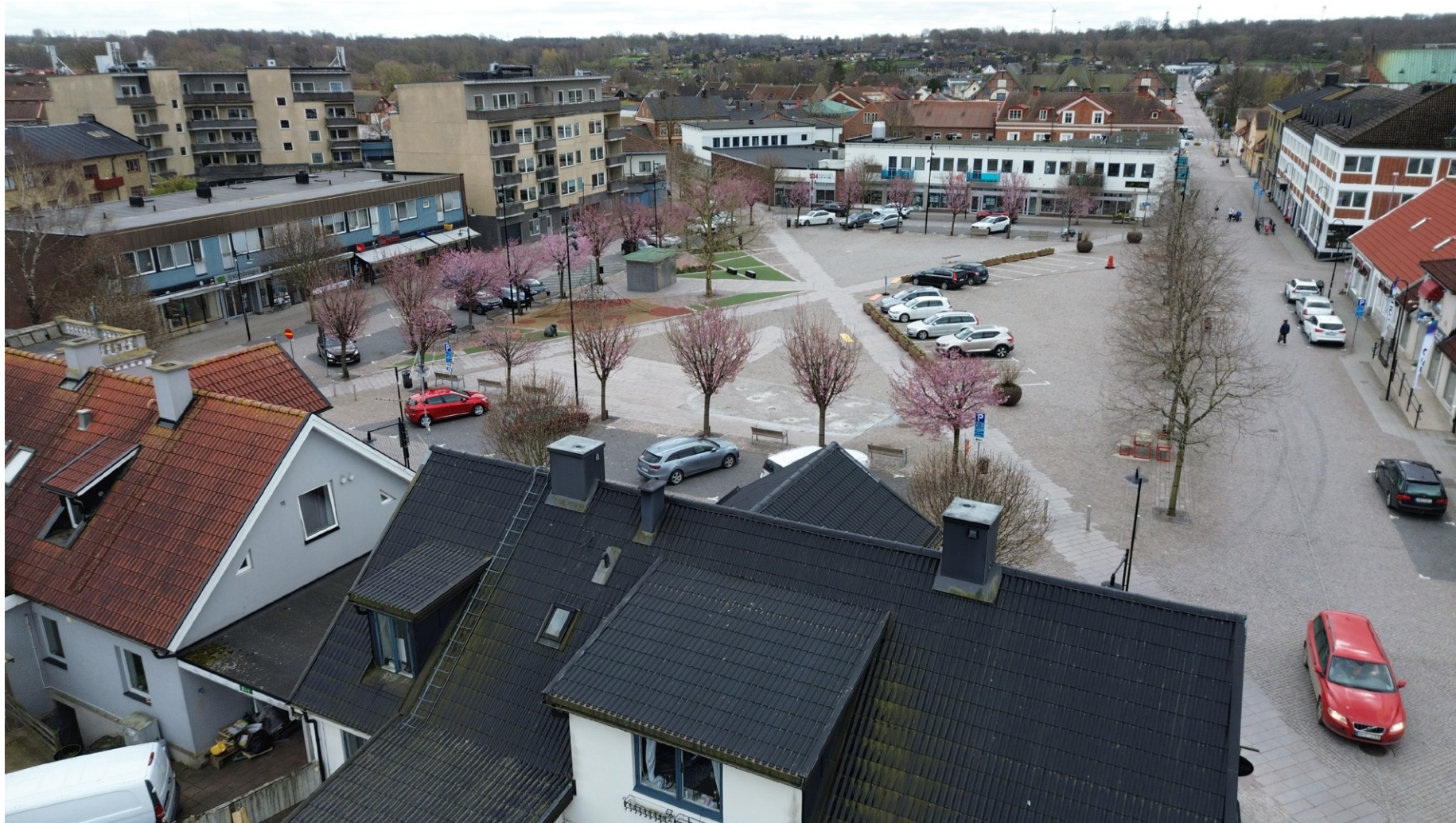
Vy över Nya Torg från norr. Torget kantas av gatuhus i norr och väst, och av utbredda låga affärsbyggnader från 1960-70-talet i syd och öst. I öst reser sig två högre flerbo- stadshus från 2000-talet. Nygatans räta axel fortsätter vidare långt åt söder, och förbinder Nya och Gamla Torg
