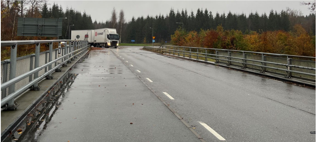
Figuren visar väg 1090 i en vy tagen från bron över E22. Befintlig gång- och cykelbana är 3 m bred, medan vägbanan är 6 m bred. Bild: WSP, 2024.
