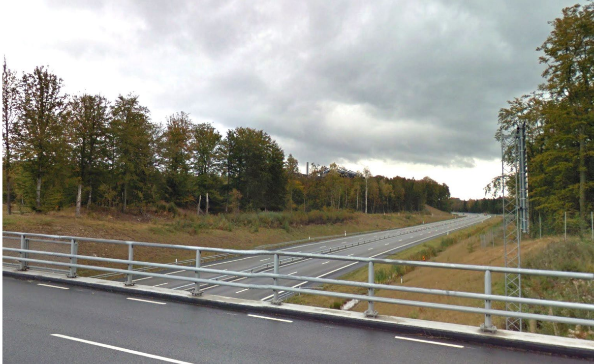
Vy från bron över E22, nära Ekerödsrasten. Från detta håll döljs anläggningen nästan helt i vegetationen och endast en ca 25 m hög skorsten och antydning till rötchkamrarnas tak skymtar på illustrationen.
