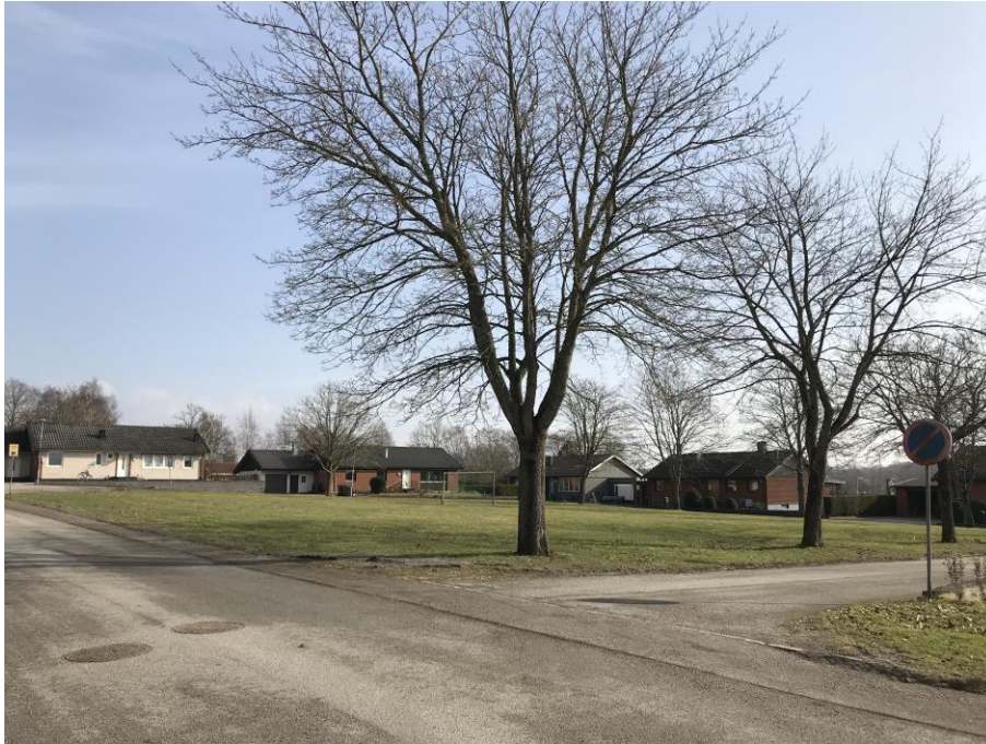
Södra delområdet, Boställsvägen, sett från nordväst.
