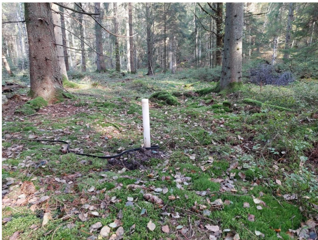
Figur 3. Grundvattenrör 23W13 Foto: WSP, 2023.
